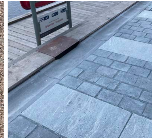
Vattenränna längs gångbana
